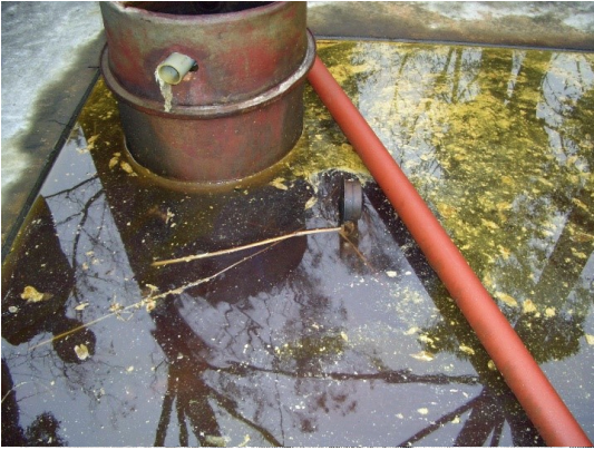
図 20. 石油樽下 石油のしみだし
