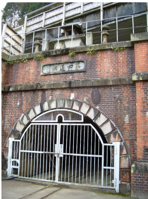
図 11. 第四通洞 大正4年貫通 長さ4600mの別子銅山の水平坑道で鉦石運搬等の大動脈であった。
